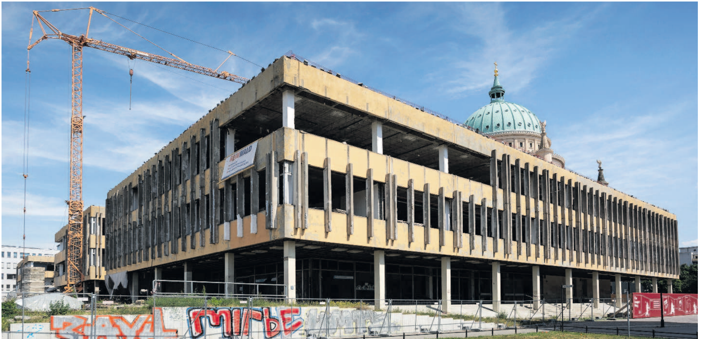
Das Motto der DDR-Hymne, „Auferstanden aus Ruinen“, gilt noch immer: Wo jetzt die Moderne in Trümmern liegt, wird ein neues pseudobarockes Viertel entstehen.
