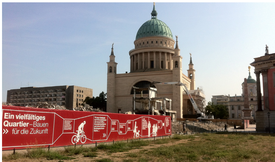
Abb. 3 Das abgerissene Gebäude der FH am Alten Markt (Quelle: Lutz 2018)
